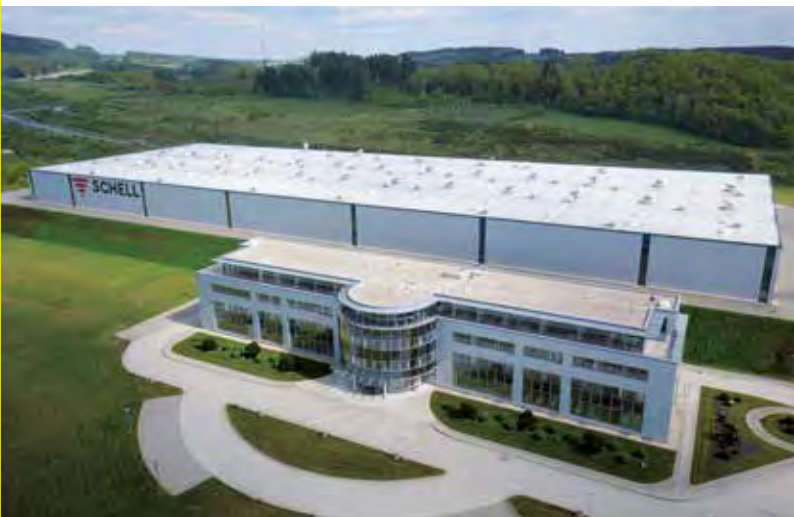
Werk 1 Produktion mit Verwaltungsgebäude und Schulungszentrum
