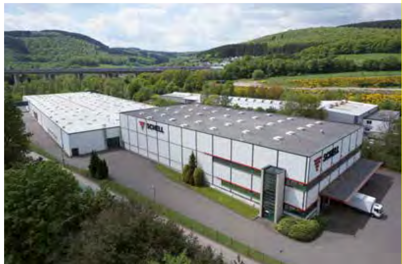
Werk 2 Produktion mit Logistikzentrum
